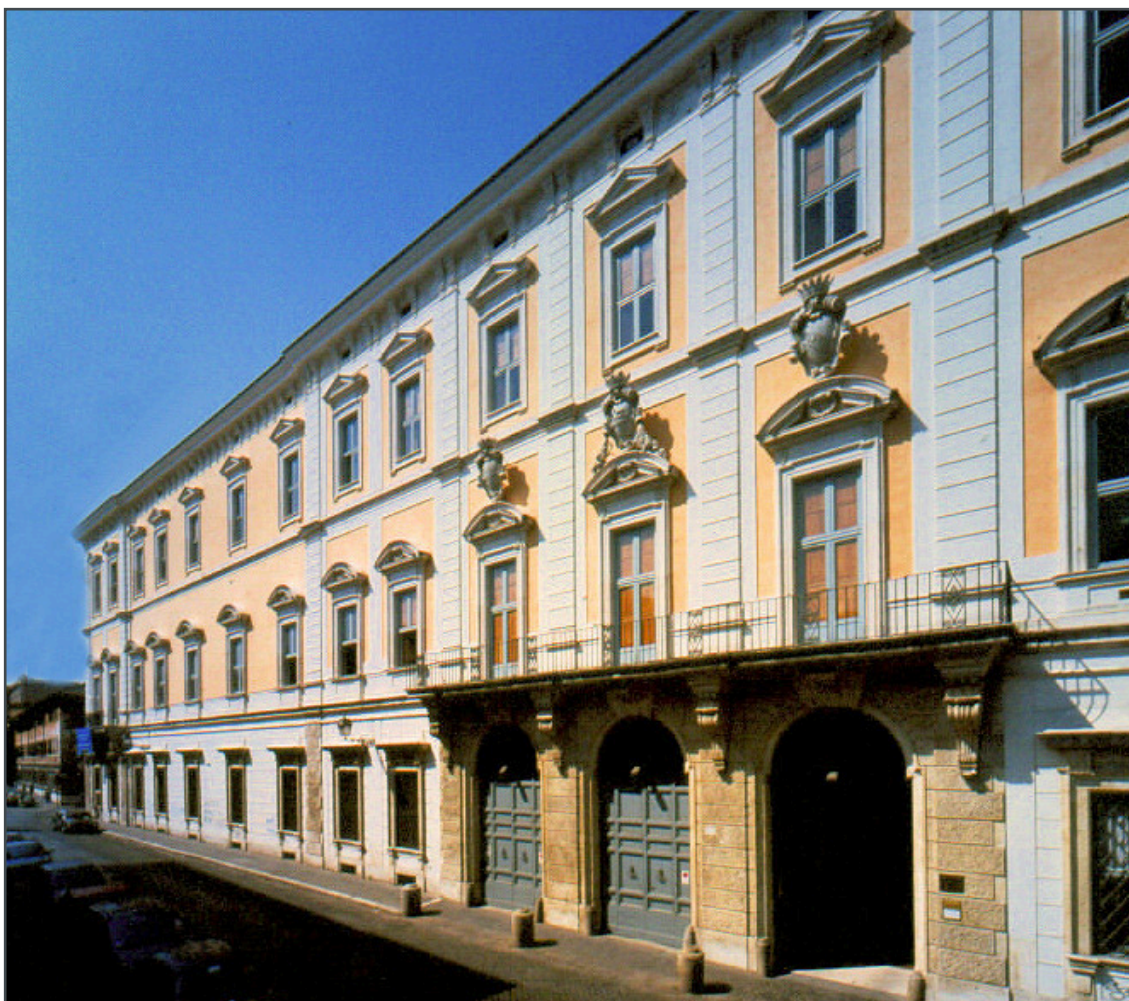
Palazzo Corsini, esterno.
